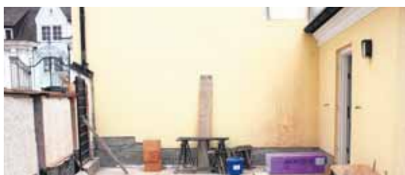
An der Nordseite des Illertisser Pfarrhauses wird zwischen dem bisherigen Anbau und der Kirchenmauer ein Konferenzzimmer angebaut, in dem zukünftig das Seelsorgeteam der Pfarreiengemeinschaft tagen wird. Foto: wis
